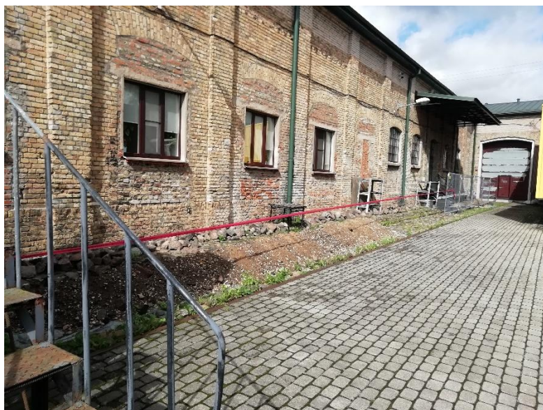
Att. Zibens novadīšanas ierīkošanas darbi, K.Pētersones–Mačukānes foto.
